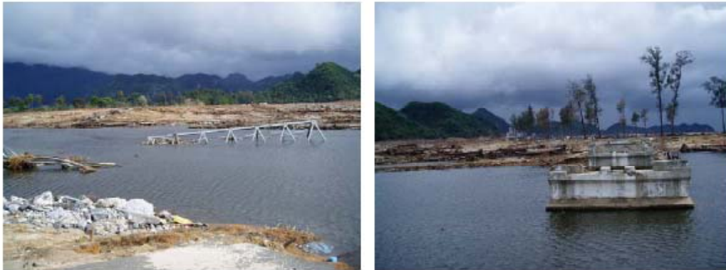
Figure 28. The Lhok Nga Bridge
