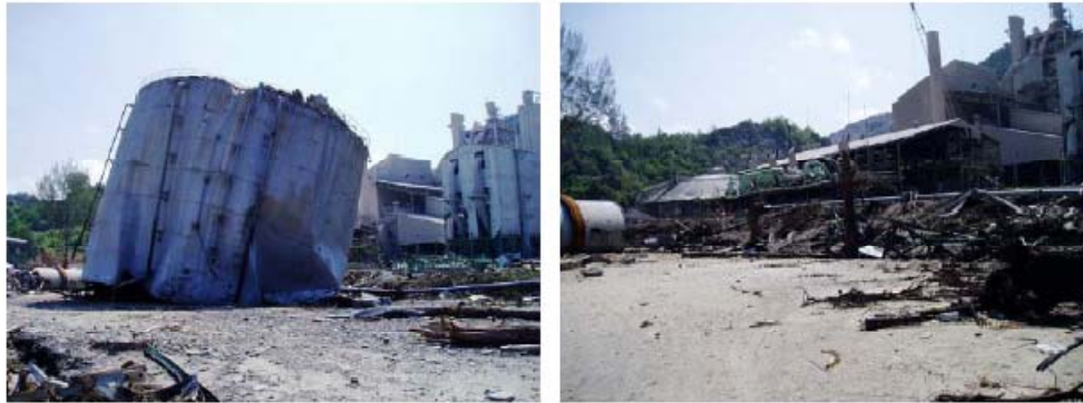
Figure 33. Cement Factory, Lhok Nga
